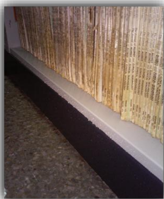
Filtración de agua de la planta superior
