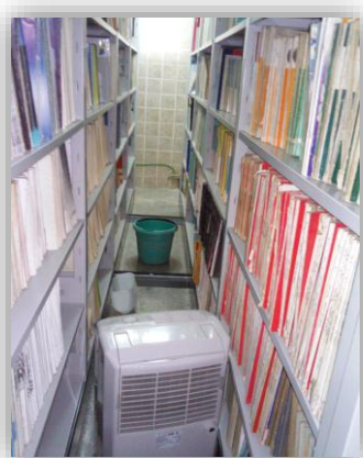
Colocación de deshumidificadores
