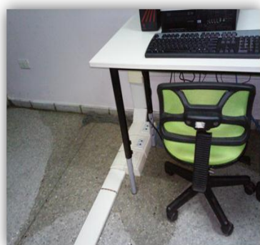
Filtración de agua por tubería del edificio
