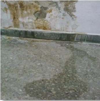
La pared lateral del Depósito de Colecciones es adyacente a una cisterna proveniente del edificio. Esto nos hace vulnerables a la ocurrencia de una inundación por filtración. En ocasiones en que se ha roto la válvula de la cisterna, ésta aumenta su nivel de agua y comienza a filtrar por la pared del depósito. Rápidamente se tomaron acciones. Se hicieron gestiones con la administración del edificio encargado de la cisterna y se reparó la válvula para evitar la filtración.
